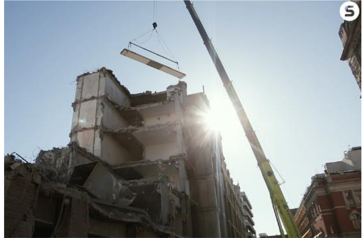
Vas. Lendagerin purkupuuprojekti, oik. Skanska ja uudelleenkäytetyt ontelolaatat. Kuvälähteet: https://group.skanska.com/media/articles/taking-a-pioneering-approach-to-re-using-concrete-decks/ https://lendager.com/project/
