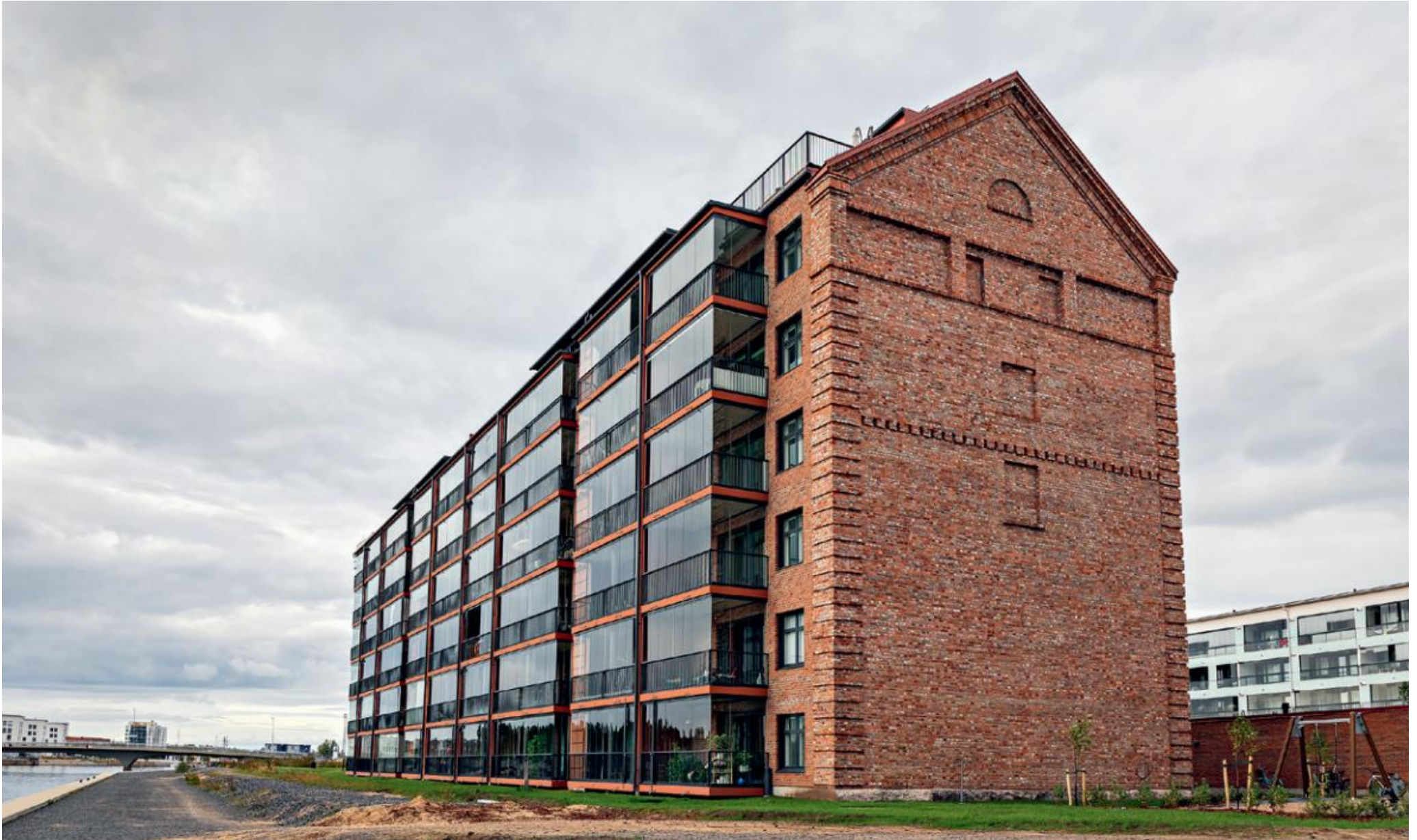
Kuva 3 As Oy Toppilan mylly, jonka päätyseinissä on käytetty lähes 100 vuotta vanhoja tiiliä. Kuva: Veikko Sarkkinen ja Vesa Ranta https://betoni.com/wp-content/uploads/2019/12/BET1904_28-35.pdf
