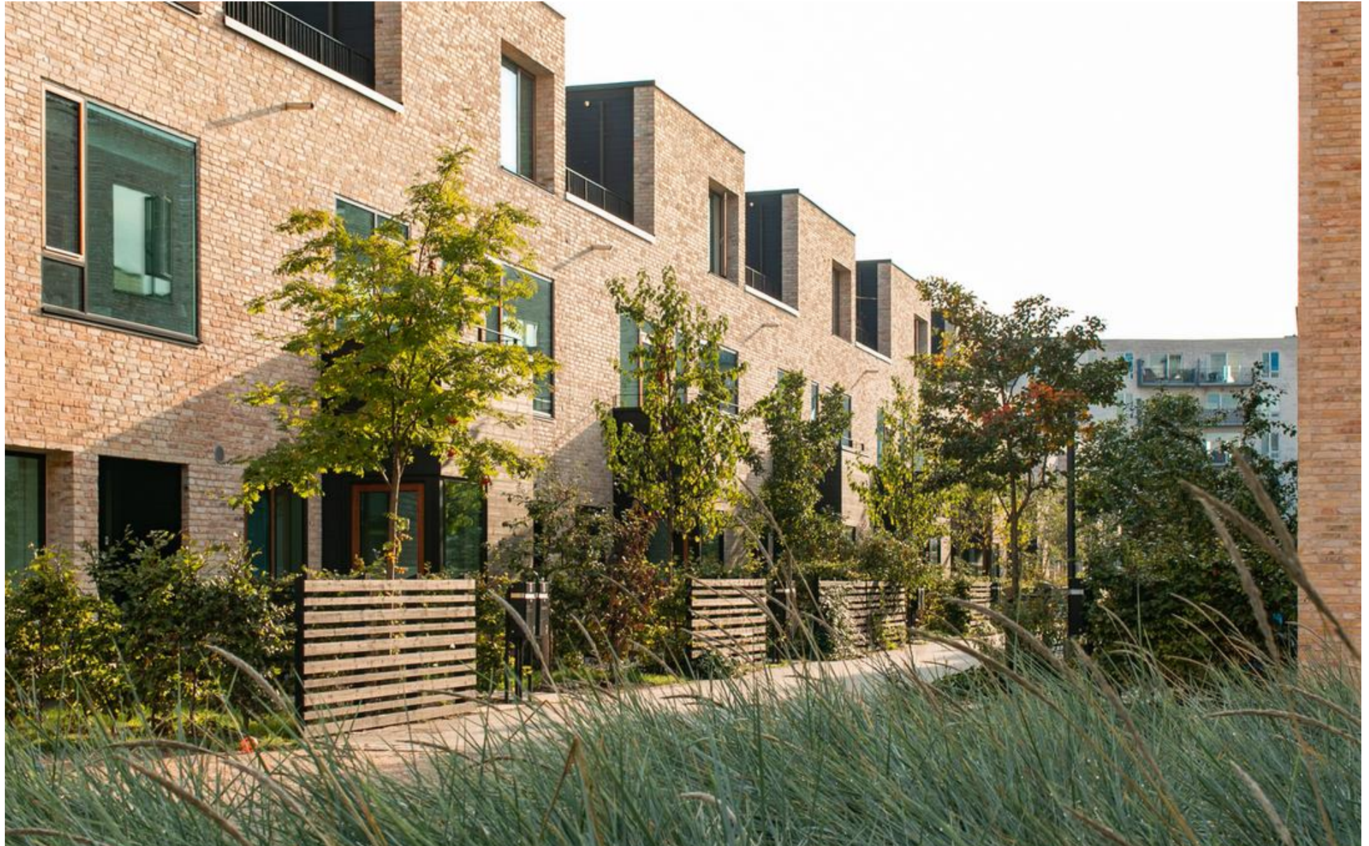
Kuva 2 NCC Oy:n uudiskohde Byhusene på Islands Brygge, jossa on käytetty uudelleen vanhoja tiiliä julkisivun muurauksessa. Kuva: Jan Albrechtsen https://vandkunsten.com/projects/byhuse-islands-brygge
